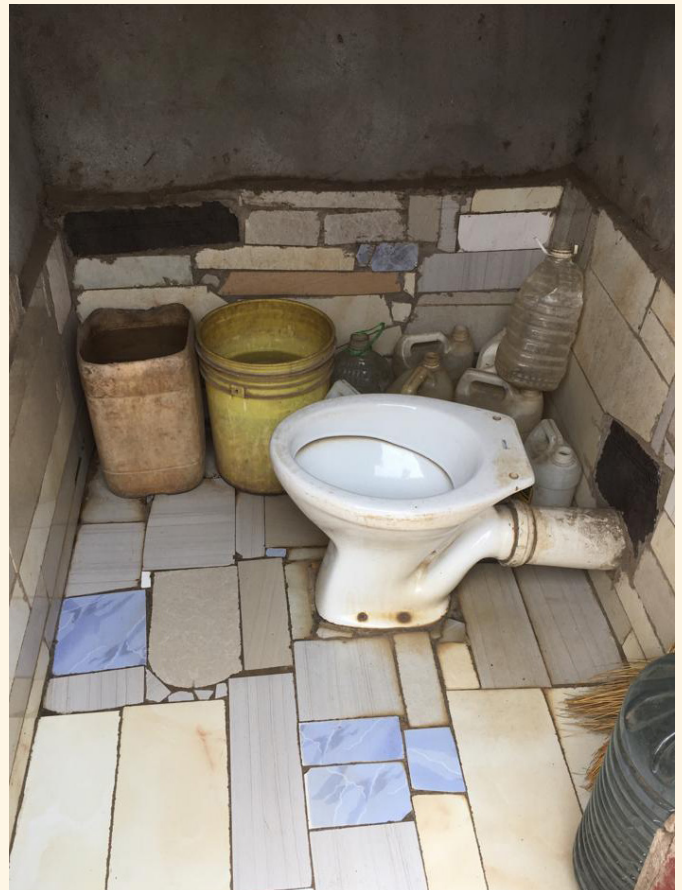
Individual Household Pour flush toilet
