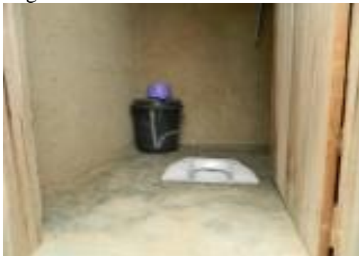
Figure 3. 4: Pour flush toilet - Interior
